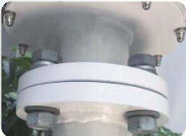
3, Instale el aerogenerador haciendo coincidir la brida del aero con la brida de la torre; utilice los accesorios provistos tuercas/arandelas y apriete las tuercas firmemente.
